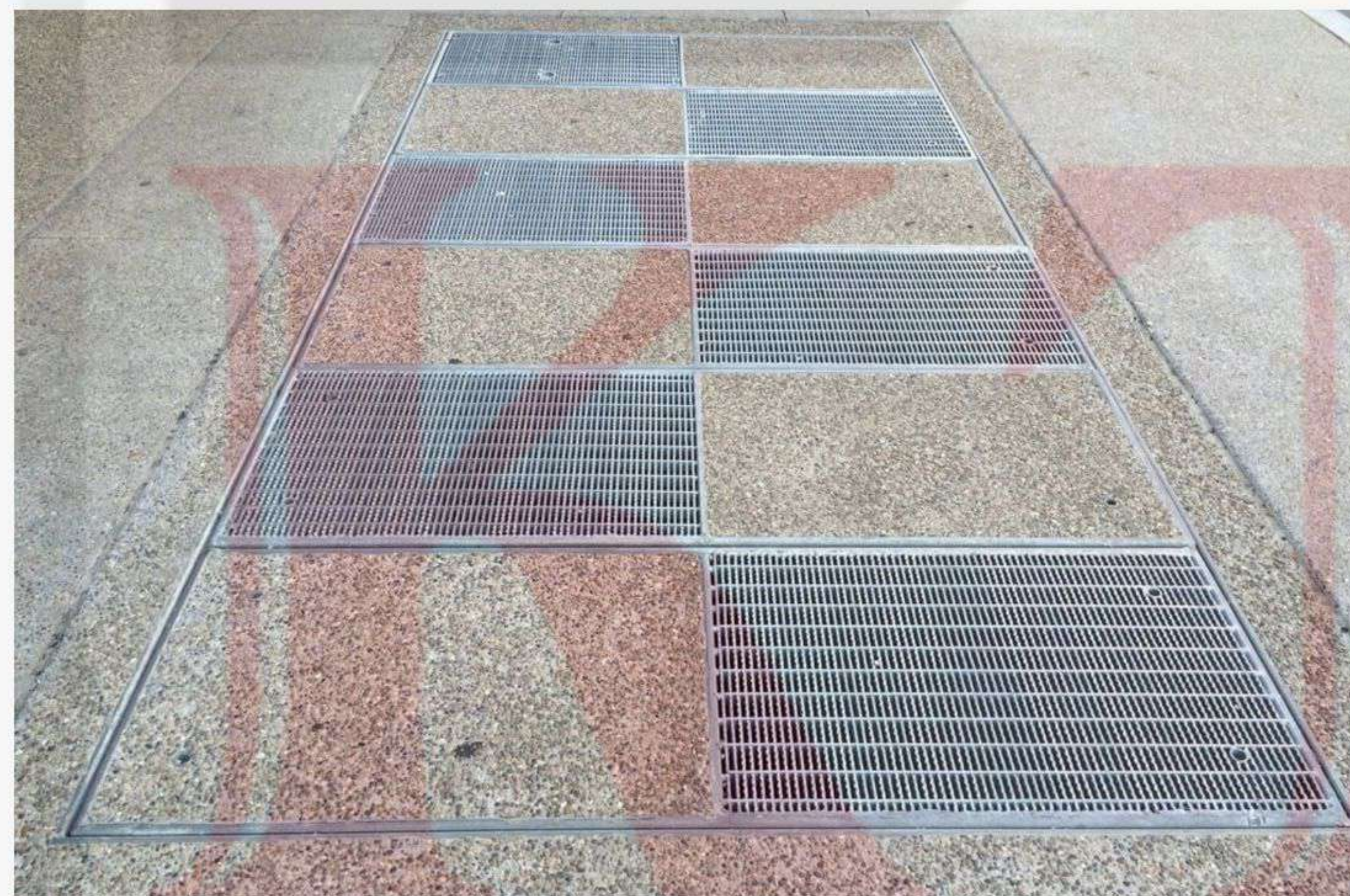
Nắp hố ga thoát nước/Grating drainage manhole cover
