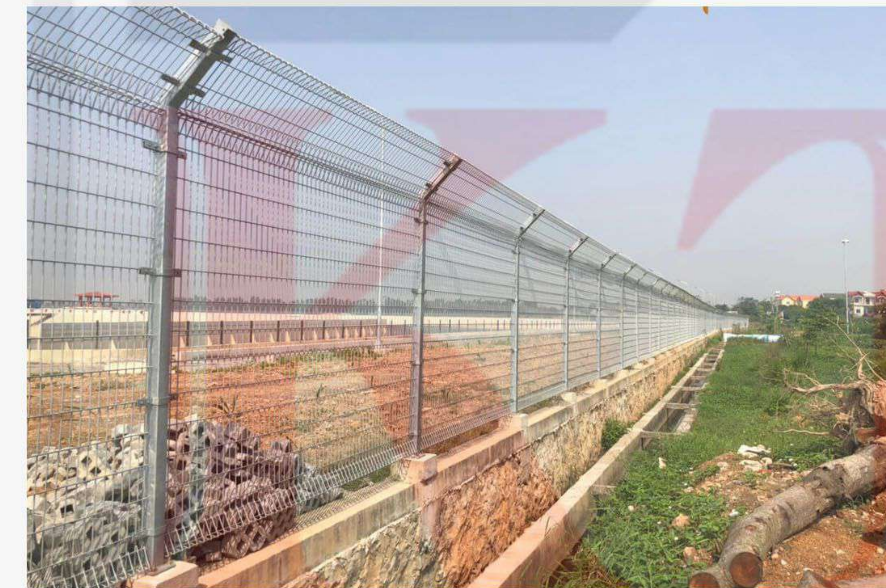
Lưới hàn rào mạ kẽm nhúng nóng/Hot dip galvanized welded mesh fence
